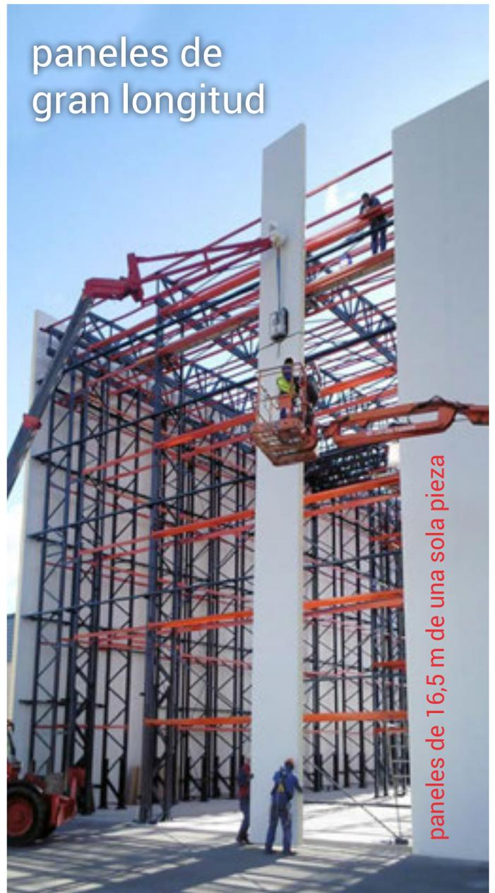
paneles de 16,5 m de una sola pieza
